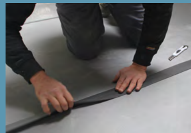
Thermisch afdichten met de meegeleverde Stickelfoam 25/70
