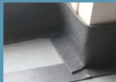
Verbinding tussen de muur en de insulit Bi+20 verwezenlijken met Lfoam 18 randstrook
