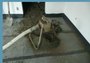
Versterkte chape gieten met een dikte van ±8 cm op insulit Bi+20
