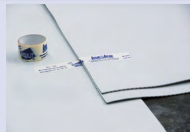
Dérouler l'insulit Bi+5 avec un recouvrement de 5 à 10 cm
