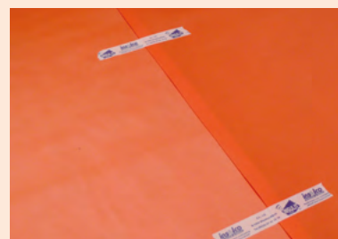
Het behoud van de overlapping verzekeren door bijgevoegde tape
