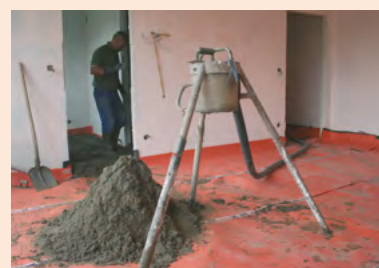
Een chape uitvoeren van \pm 8 \text{ cm} dikte op de Bi+7
