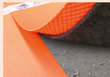
De Bi+7 uitrollen en overlappen met de schuimlaag die uitsteekt
