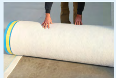
Een overlapping uitvoeren op de aangrenzende band
