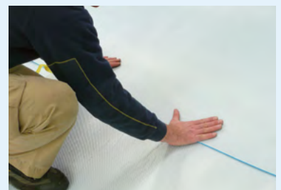
Een goede aandichting van de overlapping verzekeren
