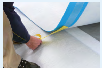
De beschermstrip van de zelfklevende band verwijderen
