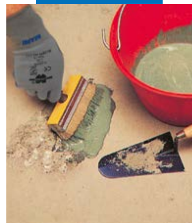
Vloer opvulling: aanbrengen van de hechtmortel
