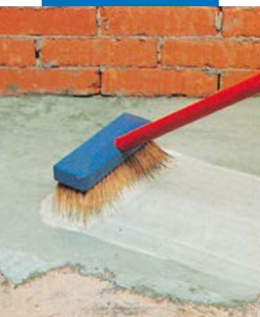
Aanbrengen van een cementmortel met toevoeging van Planicrete
