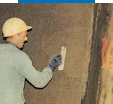
Cementpleister met Planicrete - Ville Marie snelweg tunnel, Montreal, Canada
