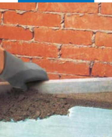
Aanbrengen van een cementdekvloer met toevoeging van Planicrete
