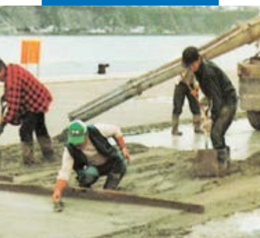
Buiten cementdekvloer met Planicrete - Vieux Port, Quebec, Canada
