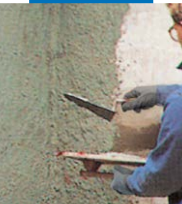
Met Planicrete aangevulde raapspecie
