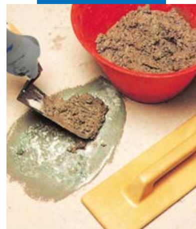
Vloer opvulling: aanbrengen van de mortel
