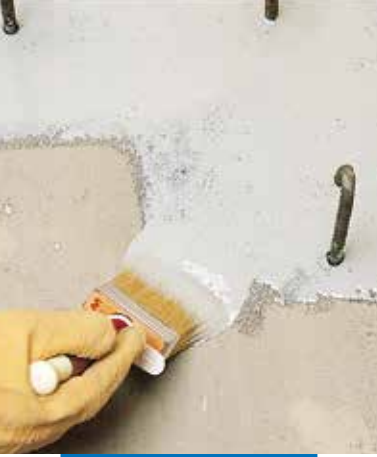
Eporip met de kwast aanbrengen op stortnaden
