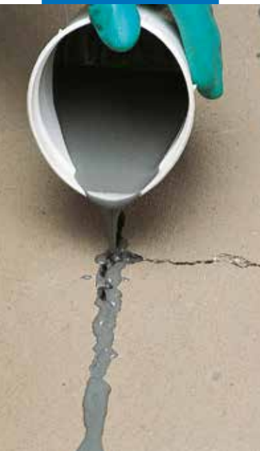
Een barst in een cementdekvloer repareren met Eporip
