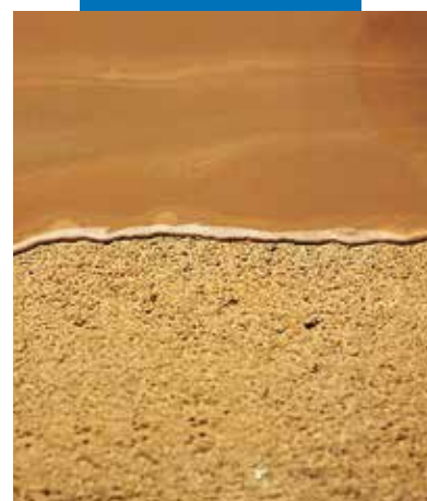
Afwerking van een Mapecem-dekvloer met het zelfegaliserende Ultraplan
