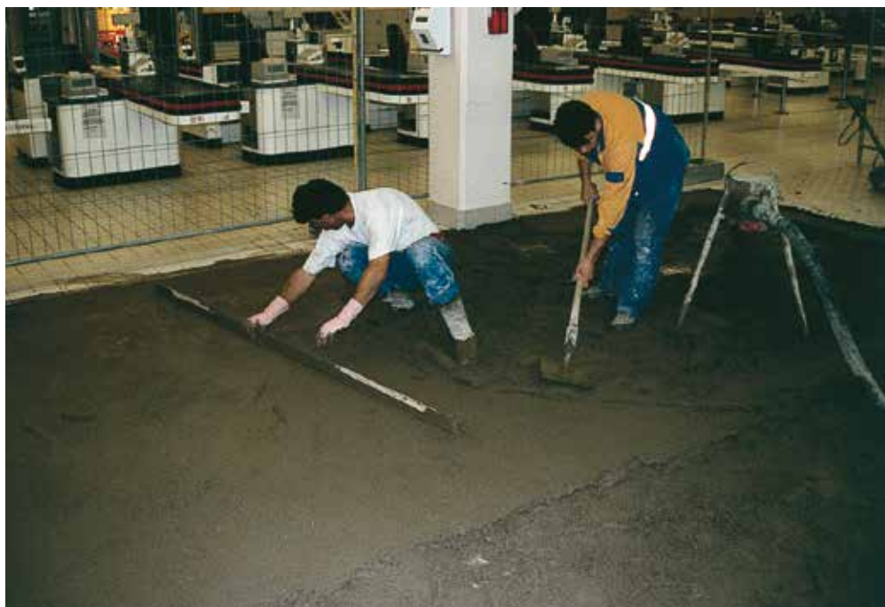
Snel herstellen van een dekvloer in een supermarkt
