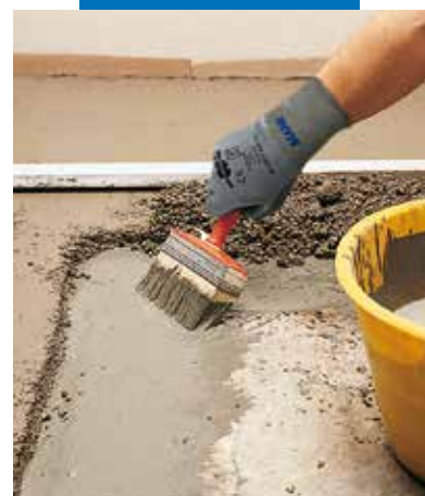
Aanbrengen van ankermortel voor aanhechtende Mapecem-dekvloeren
