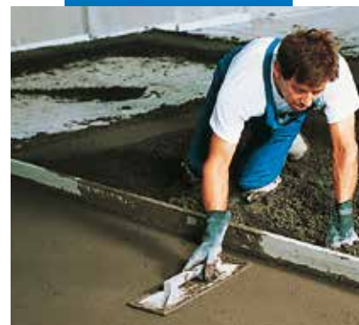
Afwerking van het Mapecem-mengsel met een strijkbord
