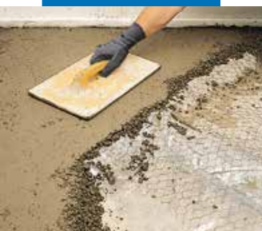
Bedekking van leidingen met Mapecem en wapeningsnet
