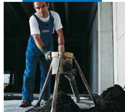
Aanbrengen van het Mapecem-mengsel
