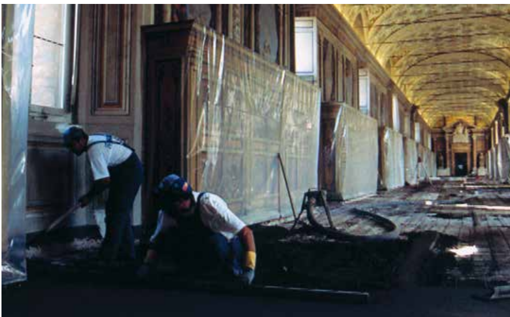
Aanbrengen en gladmaken van Mapecem dekvloer – Sistine Halls - Vaticaanstad
