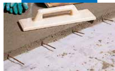
Detailfoto van een Topcem-dekvloer met staafijzers
