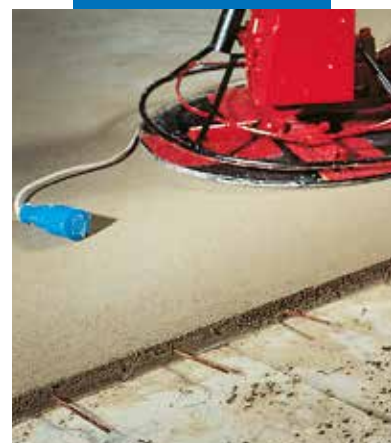
Afwerking van de dekvloer
