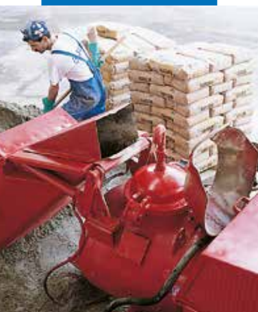
Topcem-mengsel in een automatisch pompsysteem
