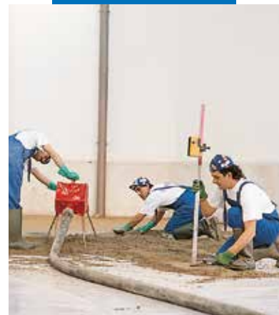
Aanbrengen van het Topcem-mengsel
