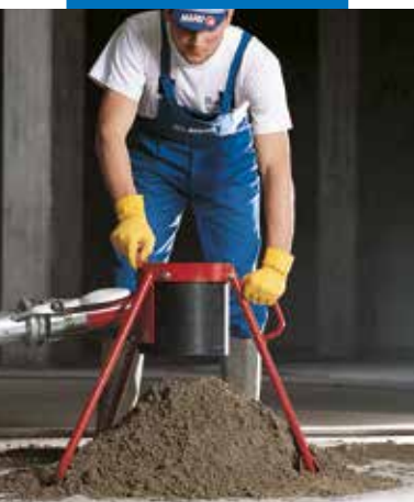
Toevoer van het Topcem-mengsel
