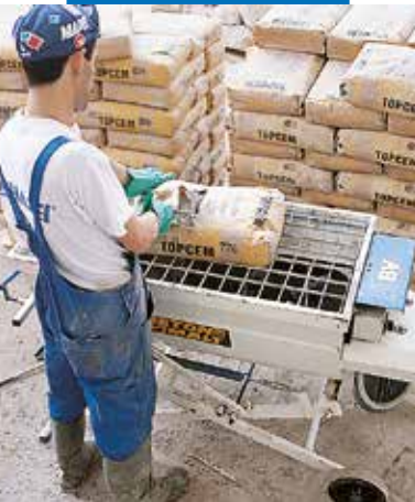
Topcem gemengd met een schroefmenger
