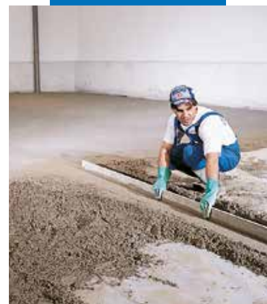
Aanbrengen van verschillende niveaus
