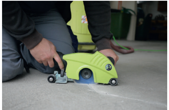
Dekvloerscheuren en voegen verbreden en haakse sleuven slijpen, heel eenvoudig en stofarm met de Wolff EF 135 voegenslijder.
