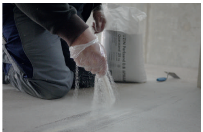
Gladgestreken UZIN KR 516 in verse toestand met UZIN kwartszand midden (0,4 – 0,8) instrooien.
