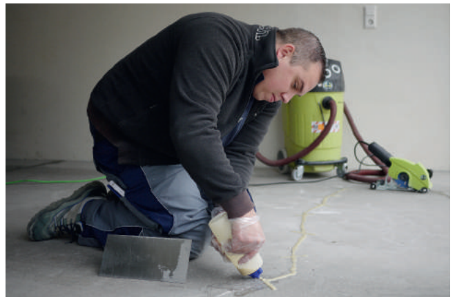
Na het uitfrezen, opzuigen inleggen van de verankeringskrammen wordt de UZIN KR 516 in de voegen aangebracht.
